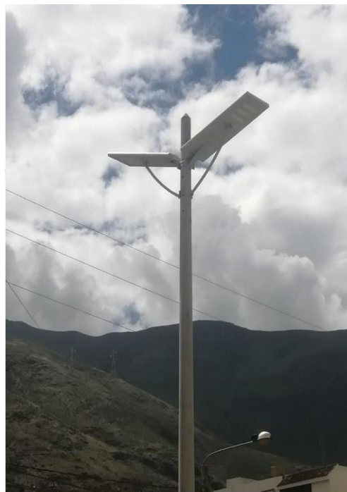
Cliente: Gobierno Regional de Huánuco Proyecto Amarilis Luminarias Solares Integradas LED 60W Vista diurna
